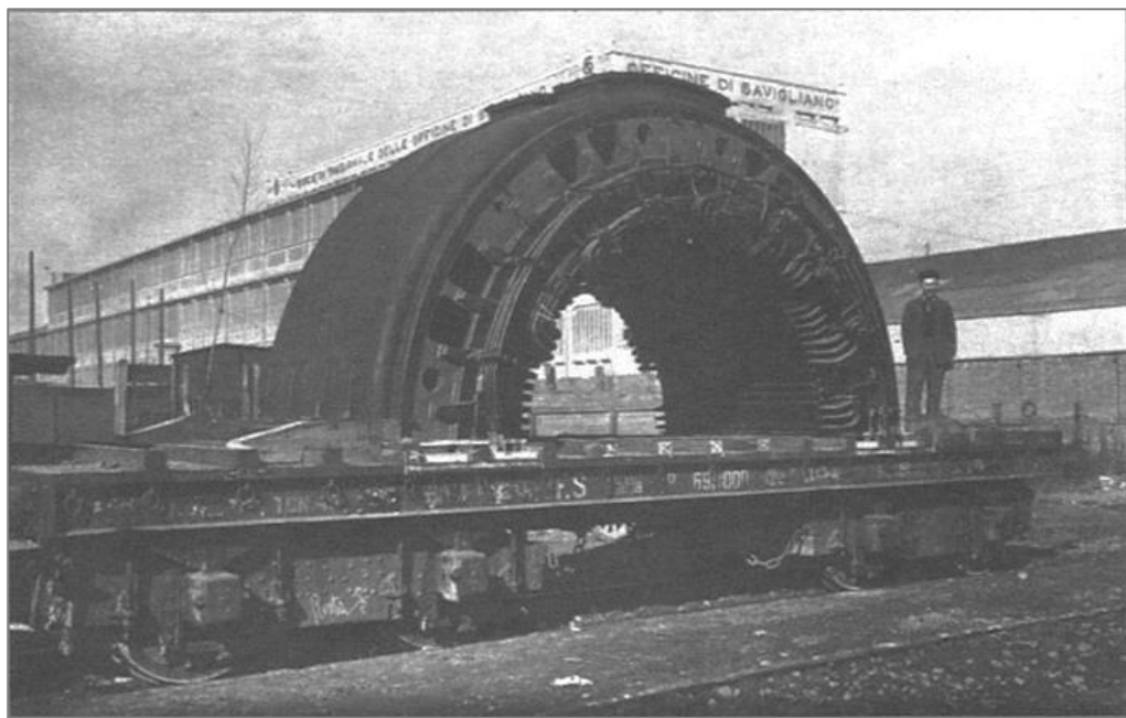
Snos Torino. Alternatore per la centrale elettrica del Sagittario delle FF.SS., fine anni Trenta (ASTo, Sez. Riunite, ASNOS, Fondo Materiale fotografico, 1359)
